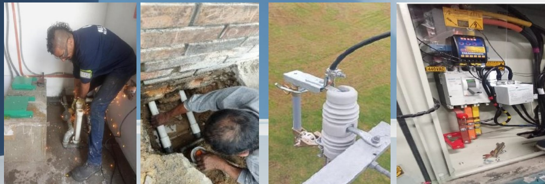
Mantenimiento integral a bombas de agua y tubería
