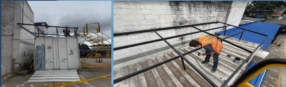
Adecuaciones cubierta container mezclas, químicos y cubierta taller de aviónica
