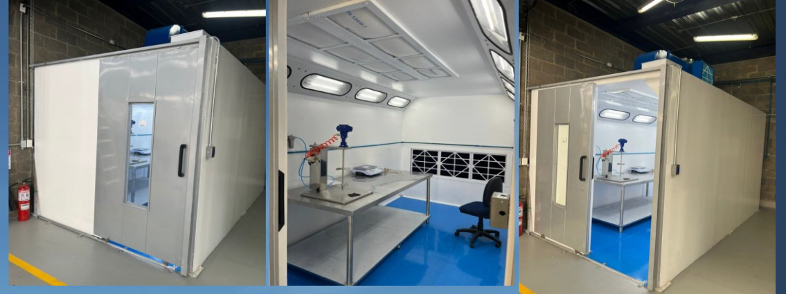
Adecuación cuarto de mezclas en CIAC Bogotá
