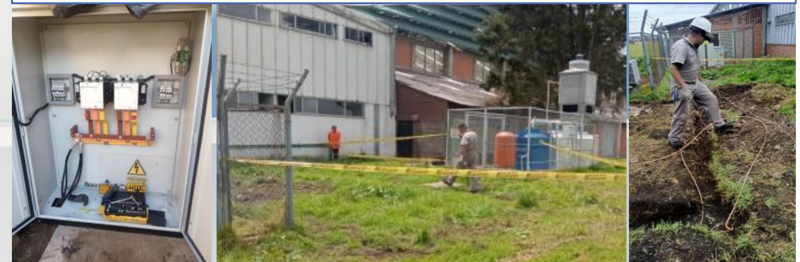
Construcción cuarto de respaldo eléctrico en las instalaciones de CAMAN - MADRID
