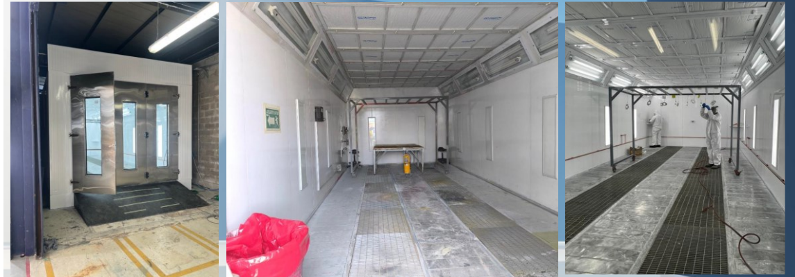
Adecuación de la Cabina de Pintura en CIAC Bogotá
